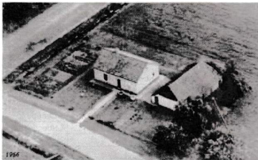
Stels foto na de afbraak van het woongedeelte, waarvoor de semi-bungalow in de plaats kwam
