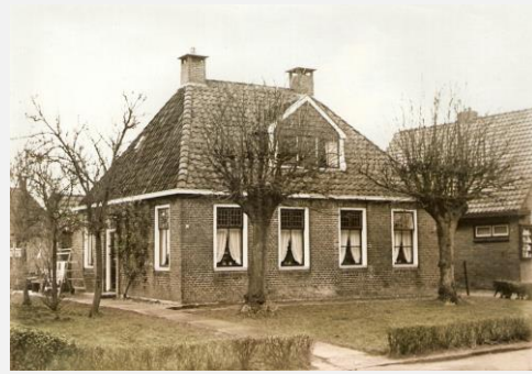
dezelfde woning, Boijlerweg 89, na verbouwing in 1947; beelddatum ca. 1955
